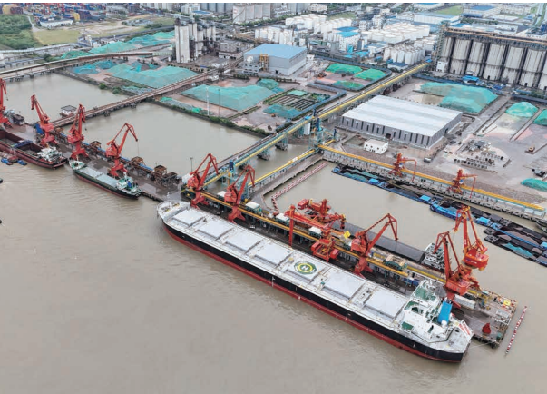
泰州永安码头改造项目
